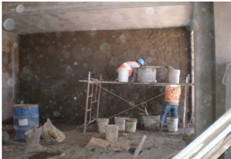
Processo di stuccatura delle pareti del laboratorio
