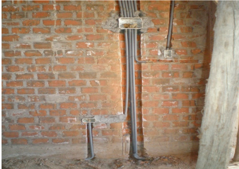
Sistemazione delle tubature interne
