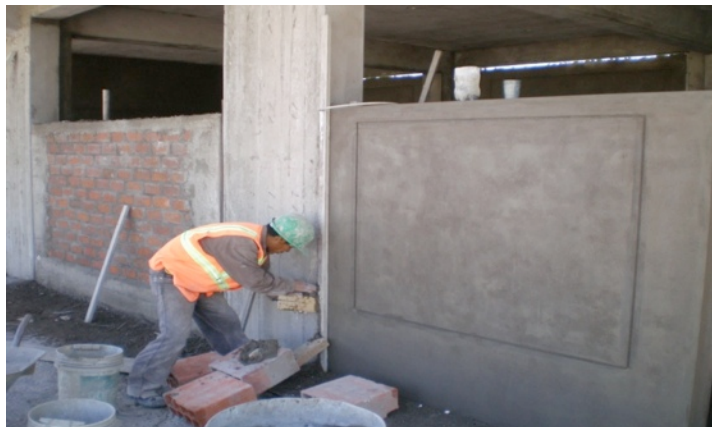
Processo di stuccatura della parte esterna dell'Atelier
